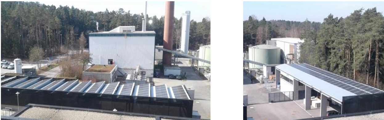
Abbildung 15: Shedhalle Ost und Nord (54 kWp und 30 kWp)
