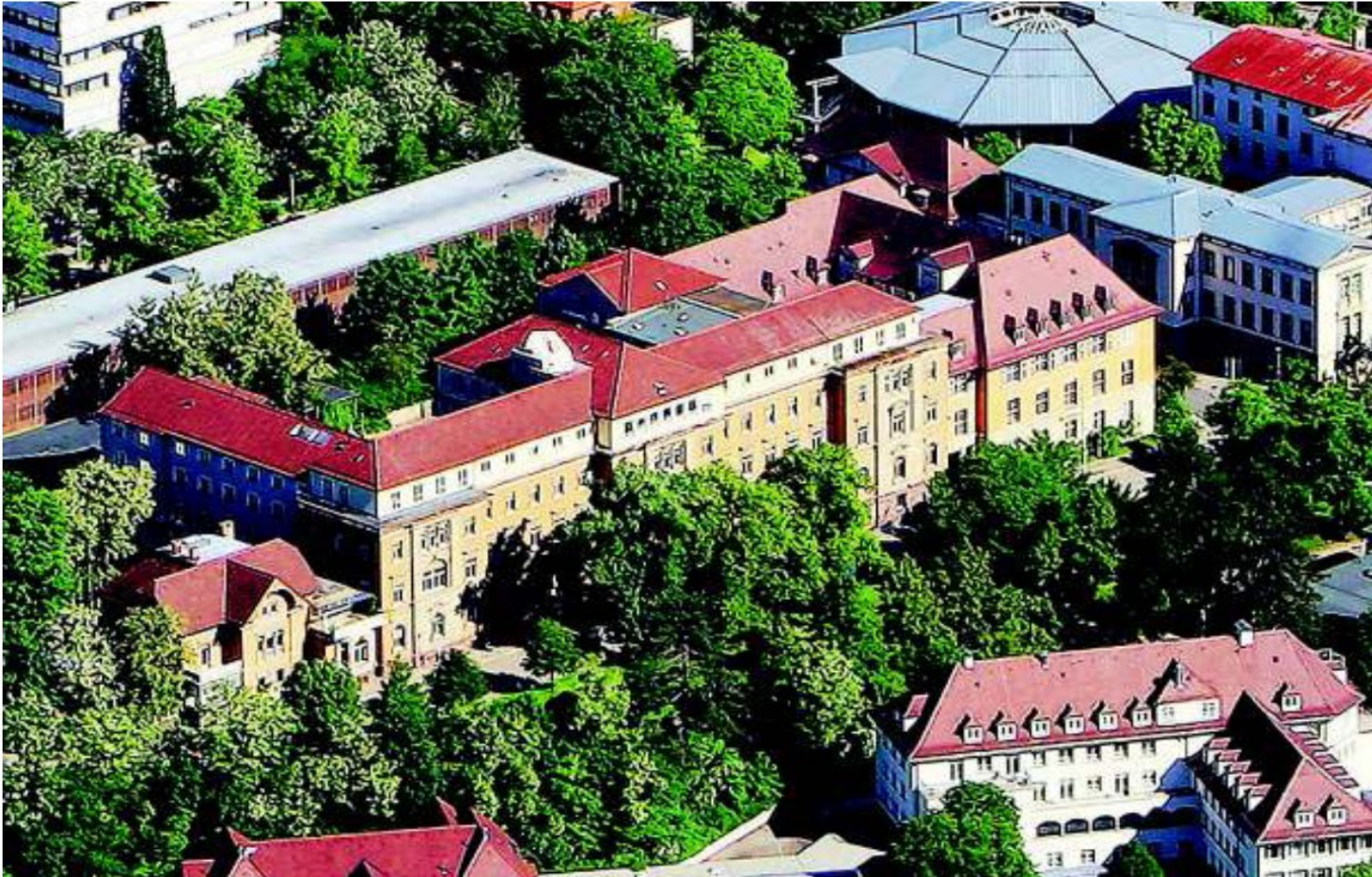
Die ehemalige Tübinger Frauenklinik ist ein imposanter Bau – künftig wird hier das Psychologische Institut unterkommen.
