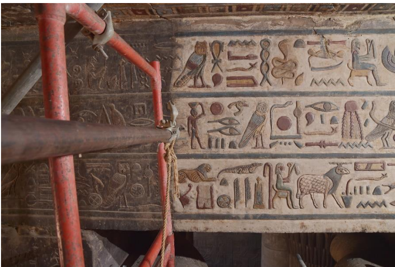
05: Vorher und nachher: Restaurierungsarbeit am Querbalken (Architrav).
