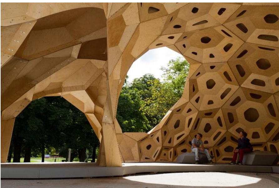
Forschungspavillion aus robotisch gefertigten Einzelsegmenten, die nach dem Prinzip von Seeigelskeletten gefügt wurden. Foto: ICD/ITKE (Institut für Computerbasiertes Entwerfen / Institut für Tragkonstruktionen und Konstruktives Entwerfen, Stuttgart)
