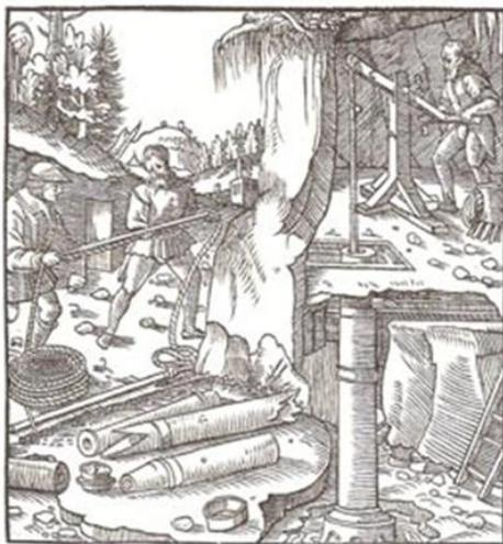
Die Stule A. Die Welle B. Der Schwengel, der sich um die Achse C. Die Kolbenflange D. Der Griff E. Der Ring, durch den die beiden Rohre verbunden werden F.
