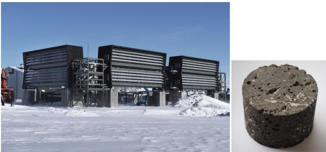
**Abb. 9.** *Links*) Direct-Air-Capture (DAC)-Anlage in Island. *Rechts*) Basalt mit Karbonatmineralien, in denen das CO<sub>2</sub> gebunden ist, welches früher in der Atmosphäre war (beide © Climeworks, Verwendungsrecht wurde erteilt).
