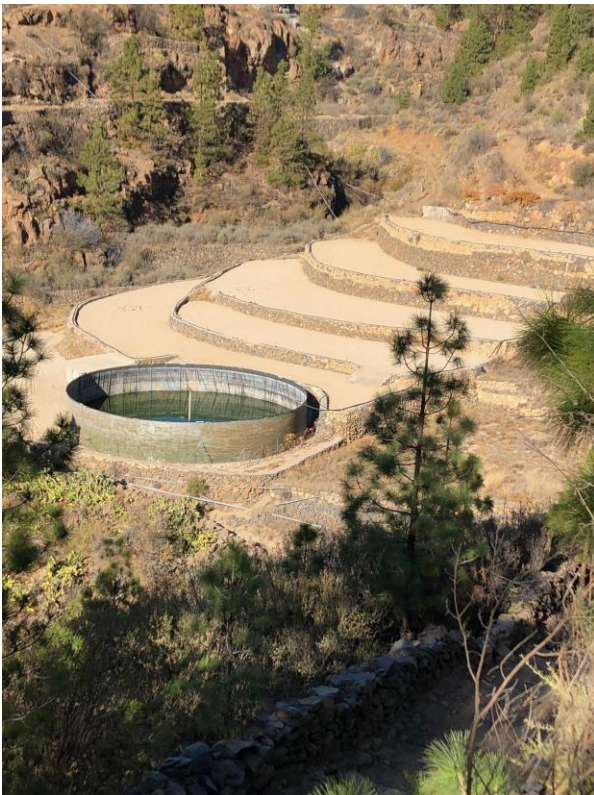
Terrasierte Regenwassersammelanlage für die landwirtschaftliche Nutzung in Vilaflor auf der Kanarischen Insel Teneriffa. Foto: Laura Dierksmeier
