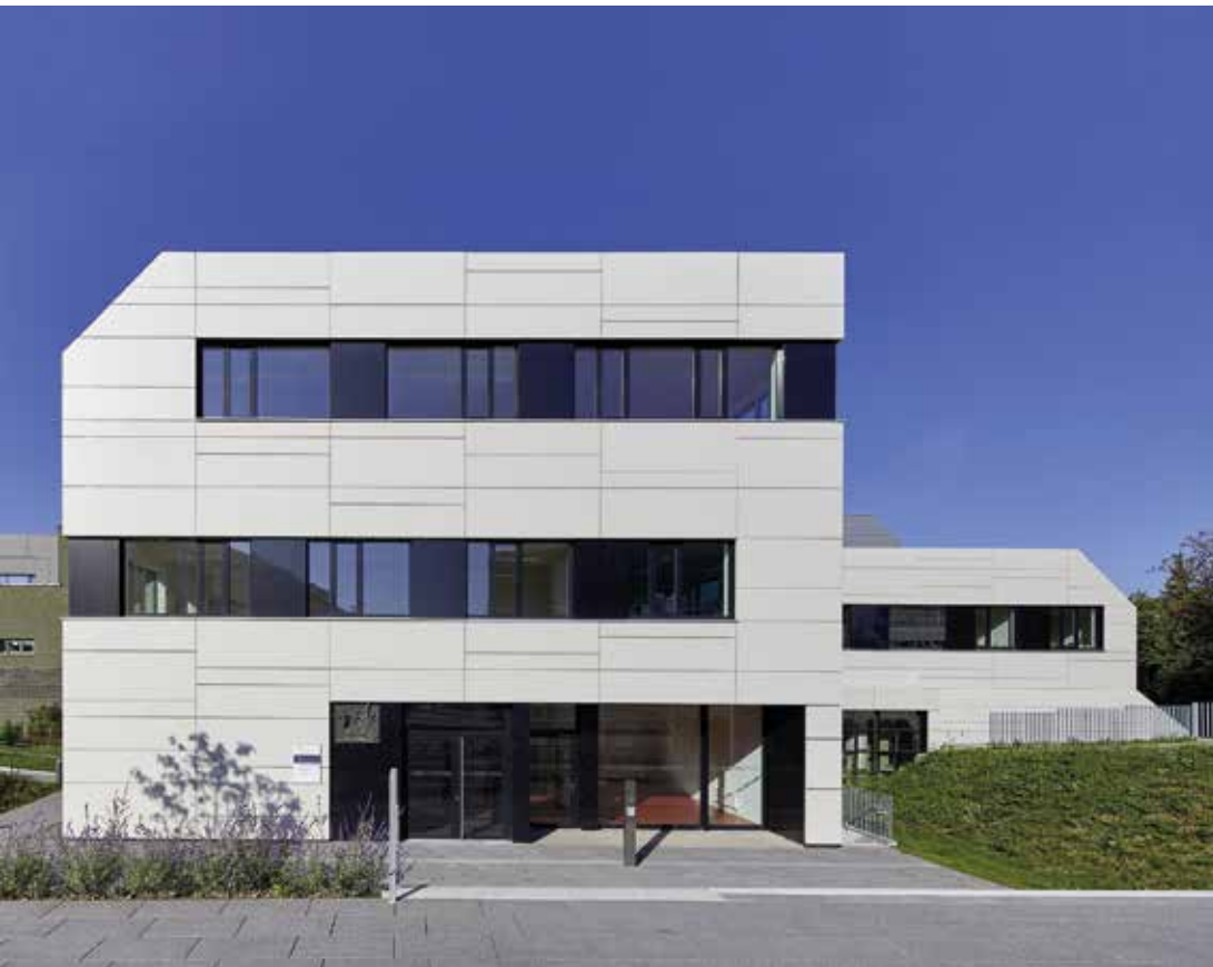
Die Klinikapotheke wurde durch Um- und Anbauten im Versorgungszentrum untergebracht und schließt so an die vorhandene Infrastruktur an.
