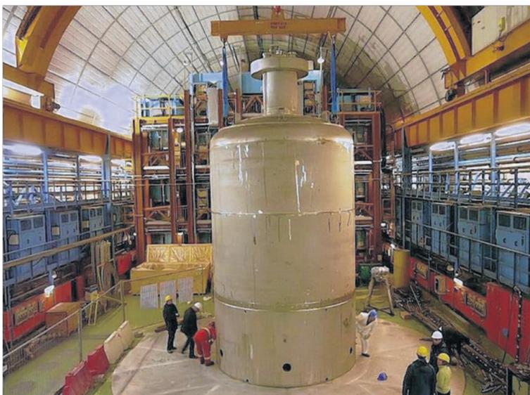
Dieser Tank wird mit flüssigem Argon gefüllt, in dem dann ein Germanium Kristall versenkt wird. Nach der Installation des Tanks begannen die Physiker, um diesen herum die Stahlkammer aufzubauen, die in einem dritten Schritt zur Spiegelkammer (siehe oben) ausgekleidet wurde. Bild: MPI Heidelberg
