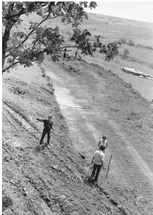
Abb. 3. Ovčarovo-Gorata. Die planierte Trasse für den Wasserkanal vor dem Beginn der Bauarbeiten im Frühsommer 1974.
