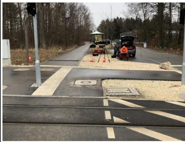
EMI1 und MP1 bis MP3 im Abstand von 10m vom Gleis
