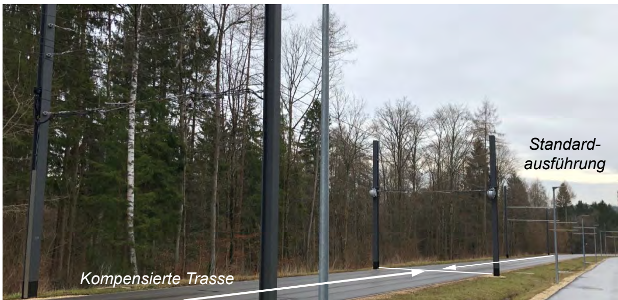
Abbildung 4-1: Straßenbahn Ulm – Übergang kompensierte Trasse und Standardausführung
