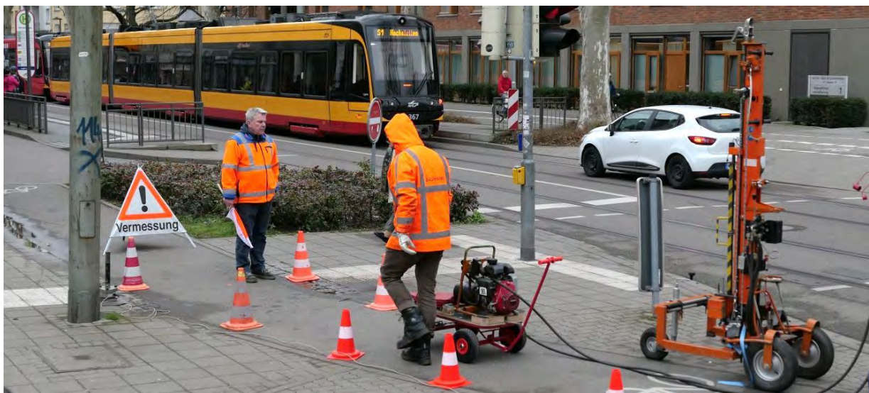
Abbildung 3-7: Referenzmessung des Zweisystem-Fahrzeugs der Regionalstadtbahn in Karlsruhe
