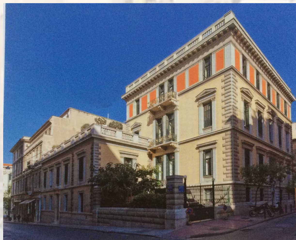
Institutsgebäude des DAI in Athen, Südostansicht (DAI Broschüre 2018).
