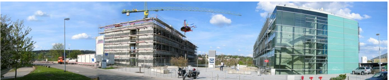
Links Forschungsgebäude für integrative Neurowissenschaften (im Bau), rechts Hertie-Institut für klinische Hirnforschung (HIH). Foto: Martin Heckler, CIN
