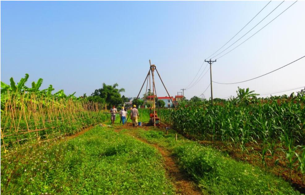
Um Sedimente für Laborexperimente mit Methan zu gewinnen, wurden 2018 in Van Phuc, Vietnam, Rotationsbohrungen durchgeführt. Foto: Andreas Kappler
