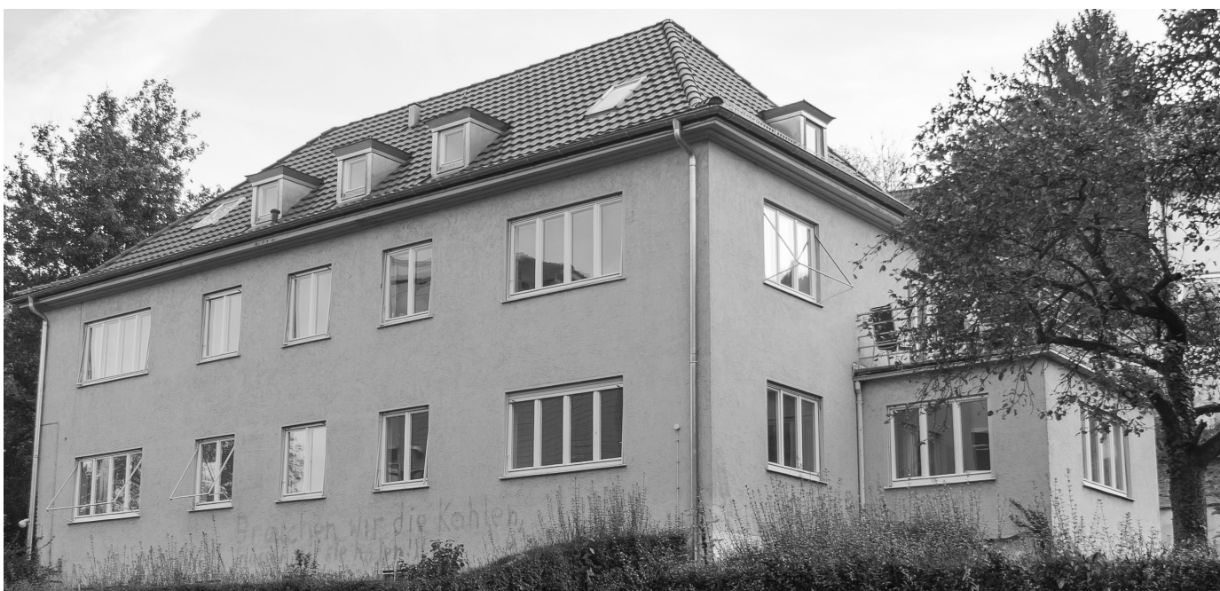
Das zusätzlich bezogene Bürogebäude in der Brunnenstraße 30
