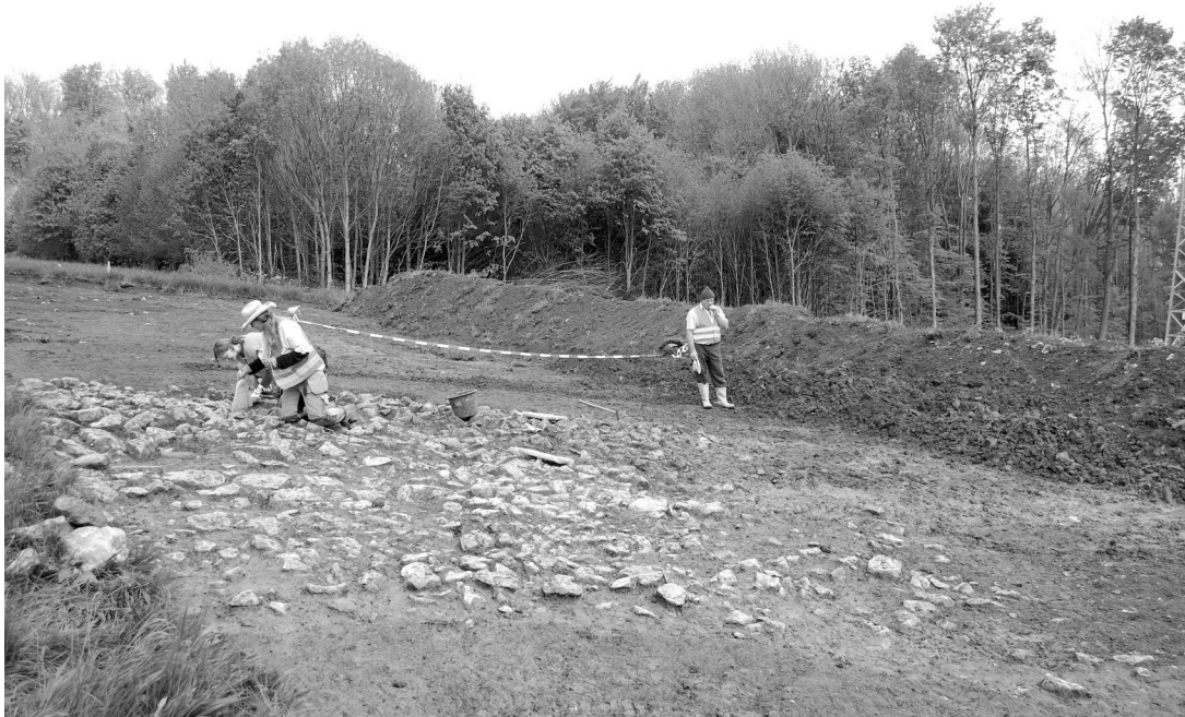
Abb. 4: Lauchheim-Röttingen. Freilegungsarbeiten im Bereich der neu entdeckten römischen Straße. Foto © LAD
