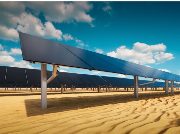
Grüne Energie ist die Zukunft: Solaranlage in Afrika Green energy is the future: Solar plant in Africa PHOTO: Petmal, istockphoto
