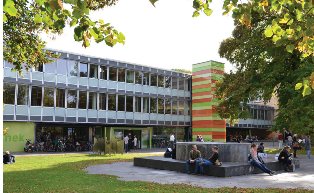
Das Hauptgebäude von 1963, seit 2011 mit buntem Aufzugsturm
