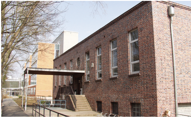
Die ‚Alte Waschhalle‘ beherbergt die Zeitschriften
