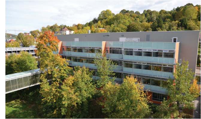
Blick zum Ammerbau (erbaut 2002)
