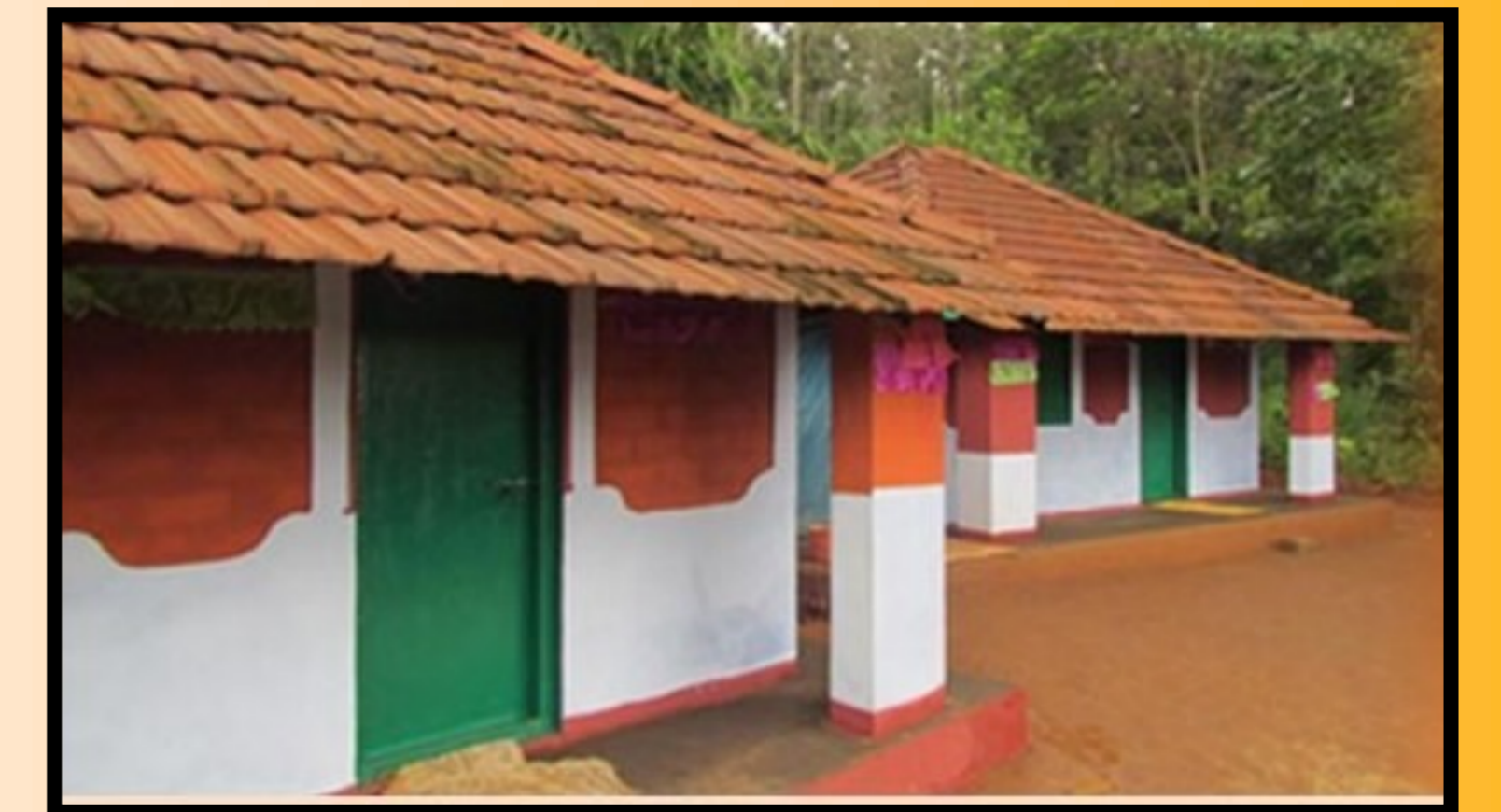
Die Häuser werden mit den Tonziegeln gebaut. Die tribalen Gesellschaften nehmen an dem Bauprozess teil
