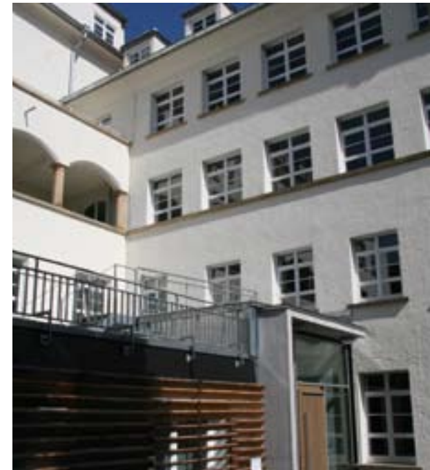
Die alte Kinderklinik in der Rümelinstraße wurde für das Geographische Institut saniert und umgebaut.
