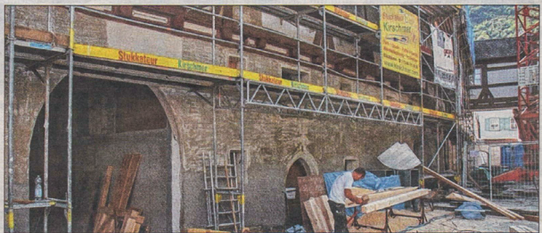
25. September 2011: Das Urmu wird ausgebaut.
