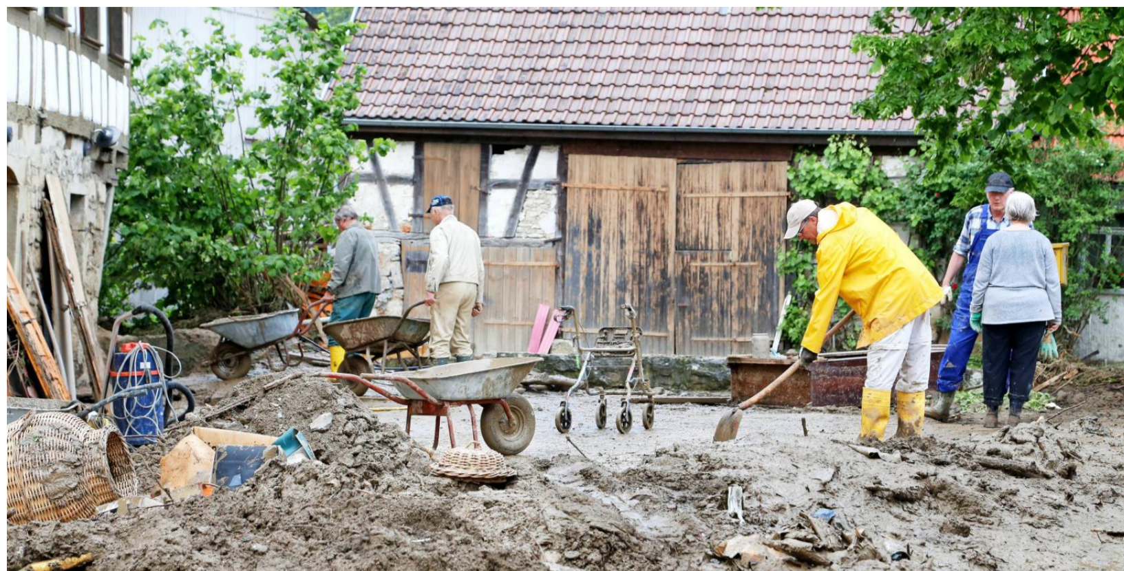
Immense Schäden hinterließ die Flutkatastrophe im Mai 2016 in Braunsbach. Wie hier mussten die Anwohner auch Schlamm und Geröll beseitigen.
