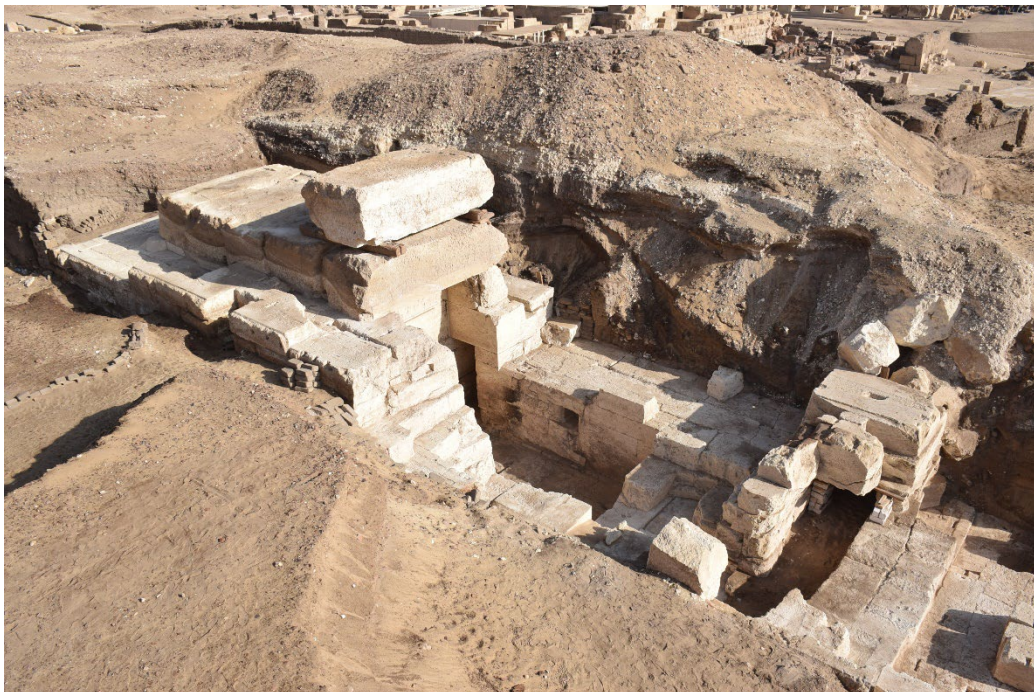
Blick auf das Nordtor des Pylons. Foto: Marcus Müller, Athribis-Projekt
