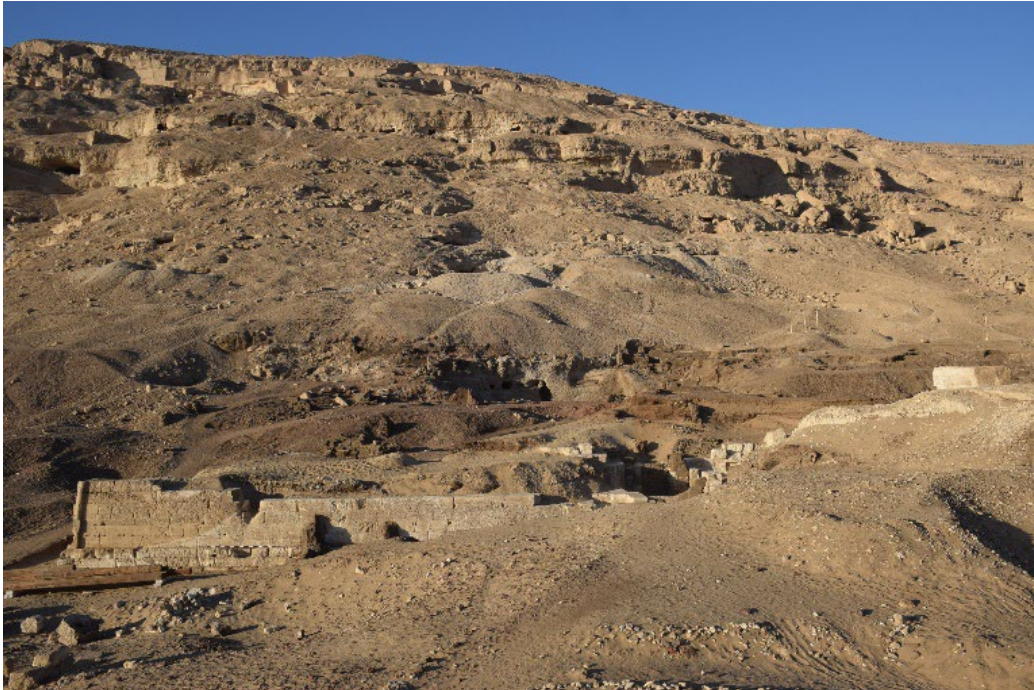
Der Südturm des Pylons und der dahinter liegende Berg, in dem ein Heiligtum vermutet wird. Foto: Marcus Müller, Athribis-Projekt
