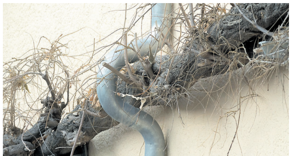
Wo die Natur stärker ist, muss das Regenwasser einen Umweg machen.
