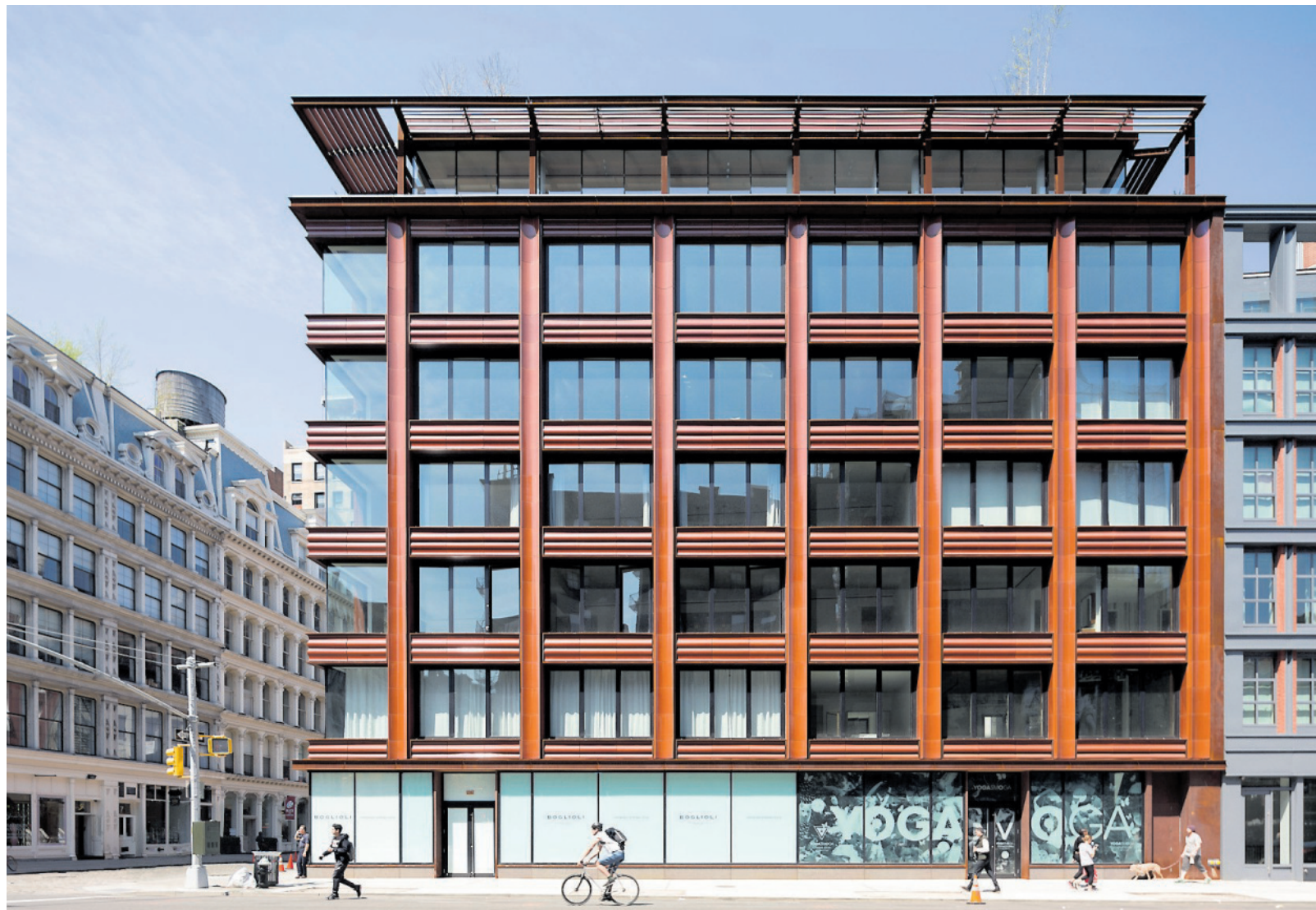
Eine Ecke in Manhattan: Maße und Proportionen sind von der denkmalgeschützten Umgebung abgeschaut, die Terracotta-Verkleidung erinnert an Backstein-Fassaden: das Apartmenthaus von Annabelle Selldorf mit der Adresse 10 Bond Street in Greenwich Village. Bild: Selldorf Architects
