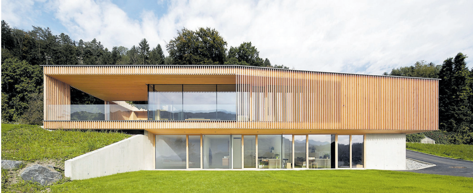
Das „Haus am Fels“ über dem Rheintal ist ein Beispiel für Helena Weber und die „Vorarlberger Schule“: Es schmiegt sich in die Landschaft, und es lässt die Landschaft herein. Verkleidet ist es mit Holz, dem traditionellen Baumaterial der Region. Bild: Büro Weber
