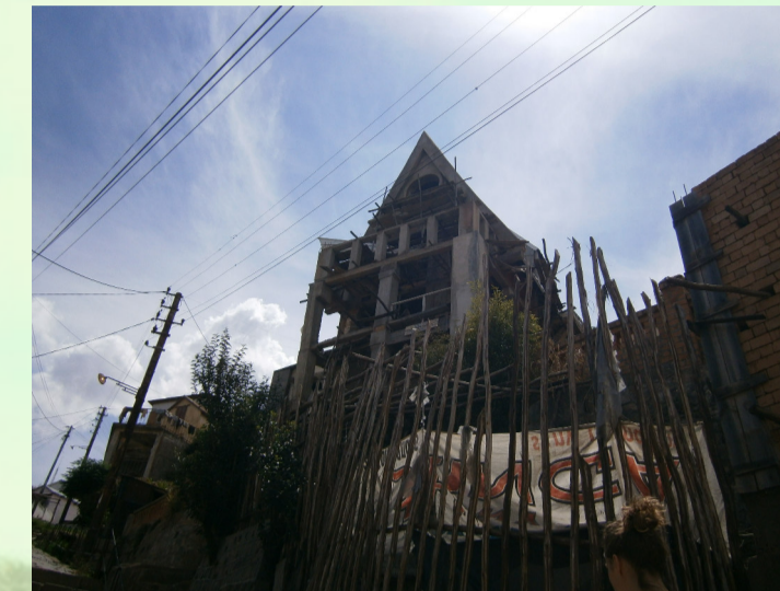
Rohbau in der Stadt
