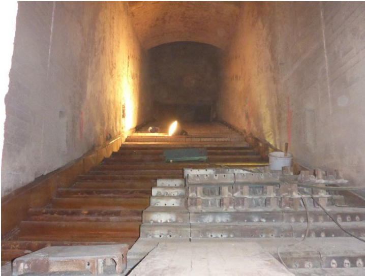
Brennraum einer Rostfeuerung, der während einer Revision instandgesetzt wird. Foto: Harald Thorwarth/ Hochschule für Forstwirtschaft Rottenburg
