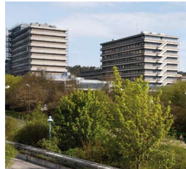
Bei den naturwissenschaftlichen Instituten und Gebäuden auf der Morgenstelle ist der Sanierungsbedarf groß. Für einige anstehende Arbeiten sollen Finanzmittel aus dem Konjunkturpaket der Bundesregierung verwendet werden.
