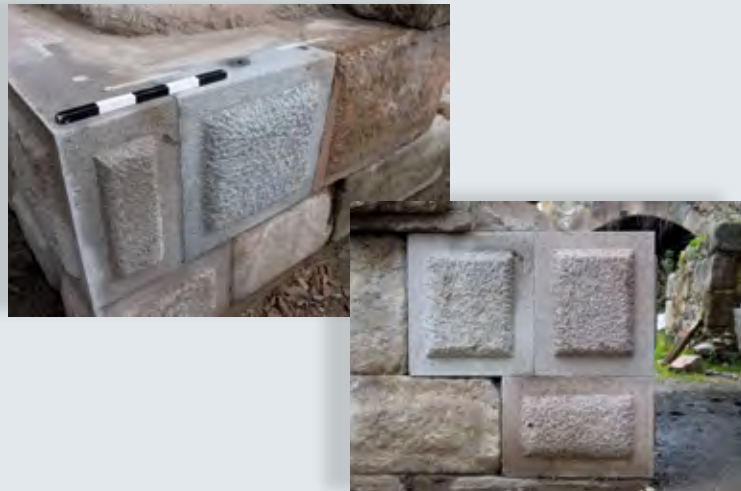
IM RAHMEN DER STEINMETZAUSBILDUNG restauriertes Fundament des Strebepfeilers in der sog. Roten Halle von Bergama. Foto: U. Mania
