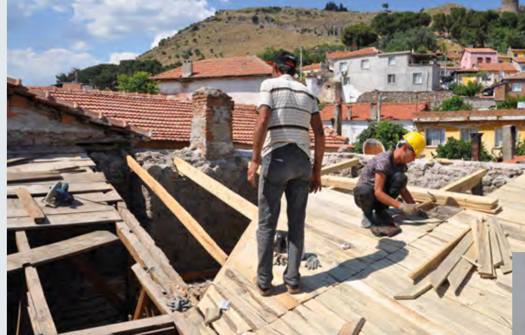
BLICK AUF DACHSANIERUNGSARBEITEN, die mit Originalmaterialien und -techniken durchgeführt wurden. Foto: U. Mania
