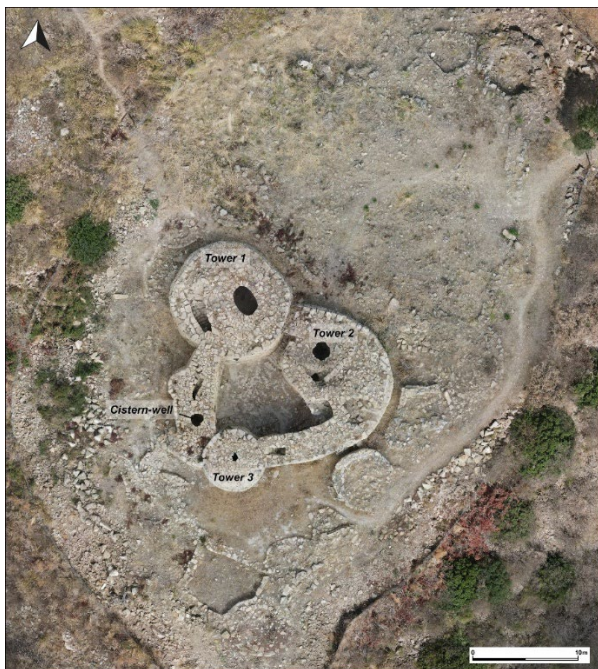
Der nuraghische Komplex Barru mit dem Zisternenbrunnen. Die aus mehreren Türmen bestehende Nuraghe ist von mehrheitlich runden Hütten umgeben. Orthofoto: Amir Ahmadpour and Lars Heinze.
