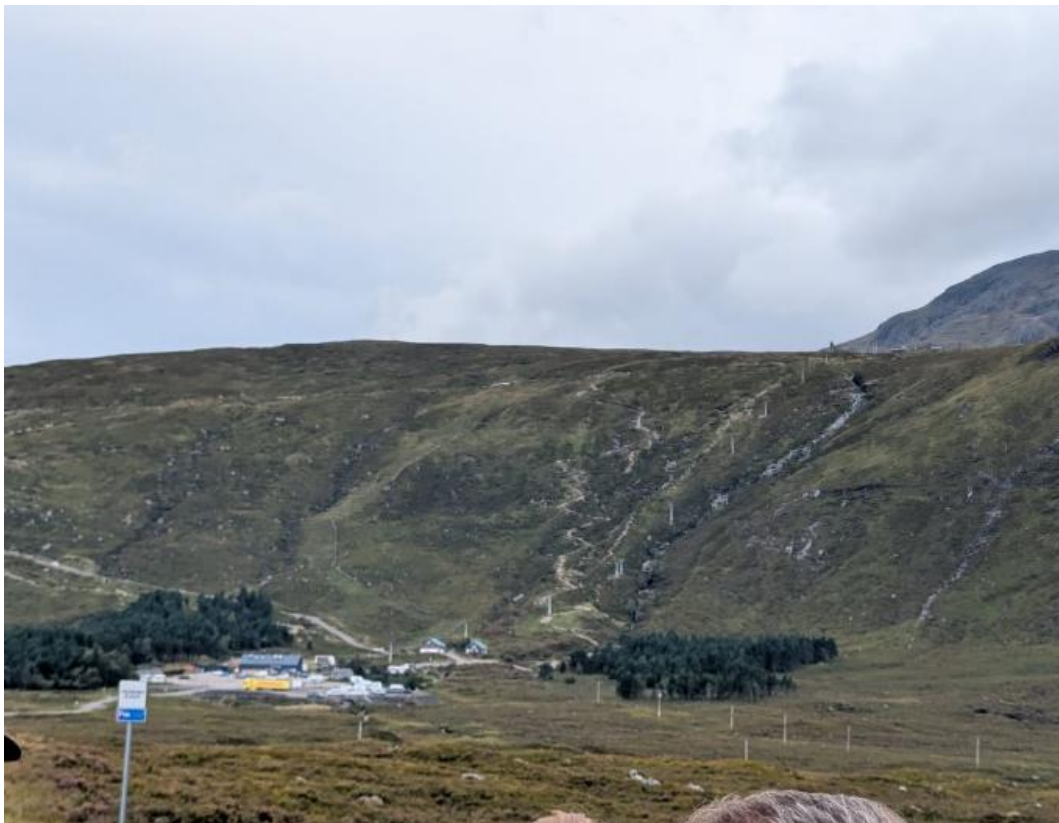
Abbildung 16: Skilift Glencoe Mountain Resort. Quelle: Eigene Aufnahme 2025.
