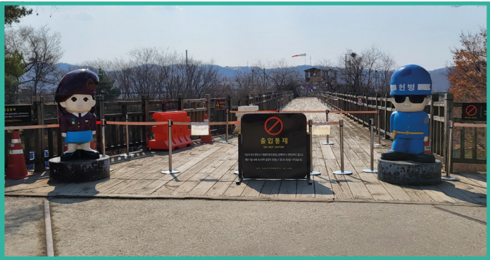
Abb. 16: Brücke der Freiheit (Quelle: Eigene Aufnahme)
