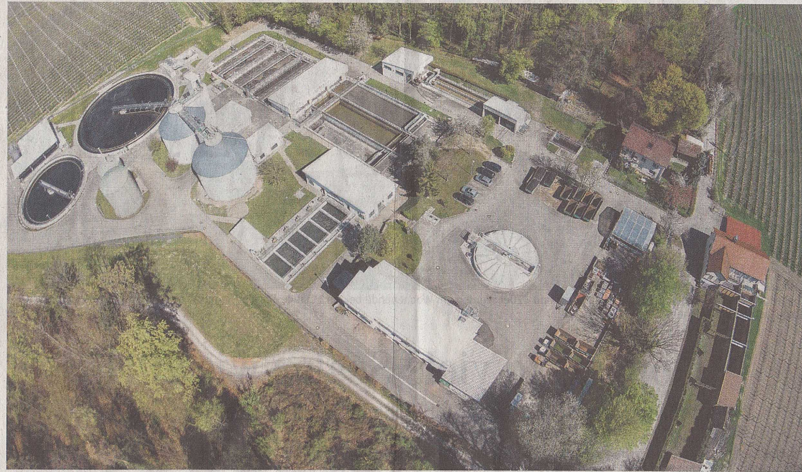
Die Kläranlage des Abwasserverbandes Kressbronn/Langenargen ist nicht Teil des Projekts „Schussen Aktiv Plus“, arbeitet aber seit vier Jahren erfolgreich mit einer Aktivkohle-Behandlungsstufe.
