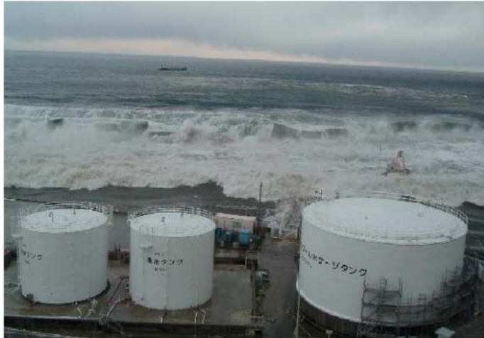
【福島第1原発 津波来襲状況 2011年3月11日 固体廃棄物貯蔵庫東側のり面(5号機の近傍(南側)から東側を撮影)＝東京電力提供
