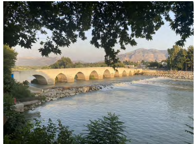
Die Brücke von Mopsouhestia
