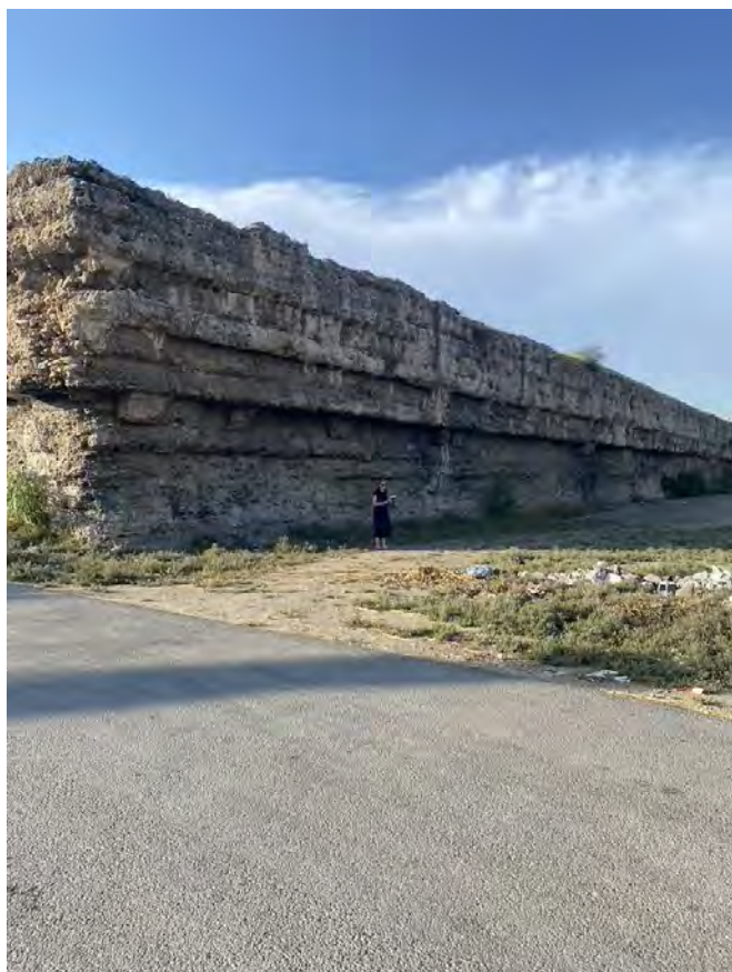
Fundament des Donuktaş-Tempels
