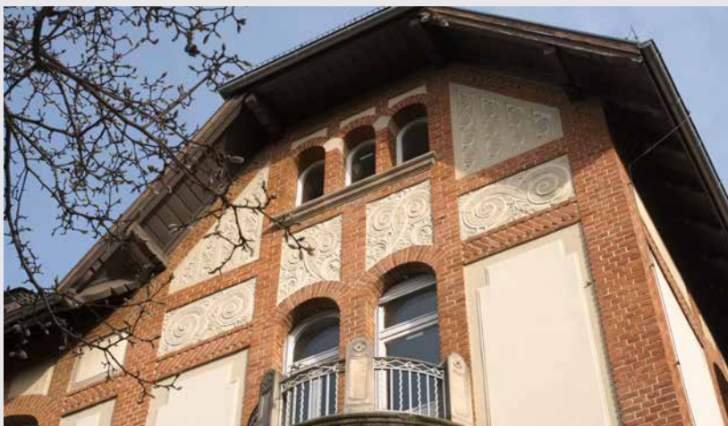
Wilhelmstr. 31: ab Sommer 2017 Gebäude der Tübingen School of Education. Derzeit wird das Gebäude saniert.
